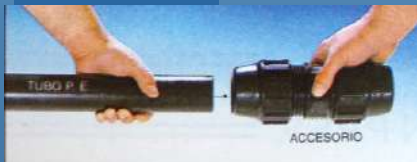
Aproximación del tubo de P.E. al accesorio
