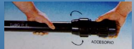
Apriete del record para sujeción del tubo de P.E.
